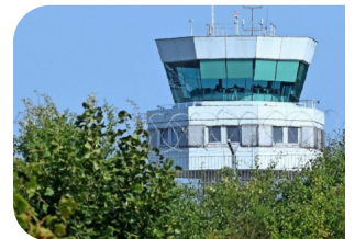
Les jours de la tour de contrôle du Luxembourg Airport ont été comptés. (photo Hervé Monta)
